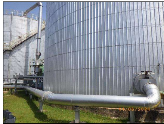
รูปที่ 2-2 การหุ้มระบบท่อด้วยฉนวนกันความร้อน
