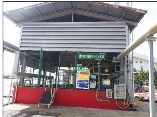
รูปที่ 2-3 ห้องควบคุม Hot Oil (Thermal Fluid Heater)
