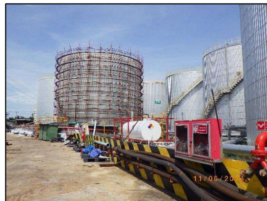
รูปที่ 2-19 กำแพงกันล้อมรอบถังเก็บแอสฟัลท์
